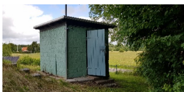
Bygning til pumper.
